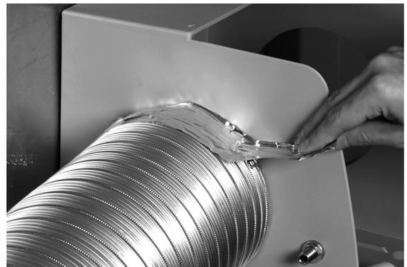
**Fig. 15. Scellage des raccords avec du ruban.**
