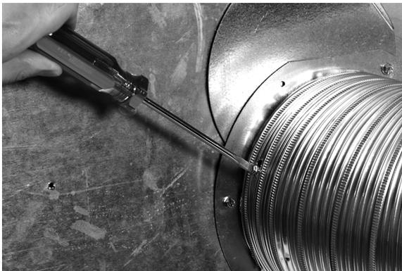
**Fig. 13. Raccordement de la gainé de dérivation au collet de dérivation.**
